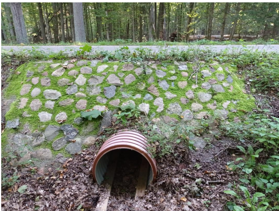
Ryc. 13.6. Przepust z tworzywa sztucznego na cieku okresowym, drożny, w stanie dobrym oddział 218C, leśnictwo Teremiski, Nadleśnictwo Białowieża (źródło: BULiGL)
