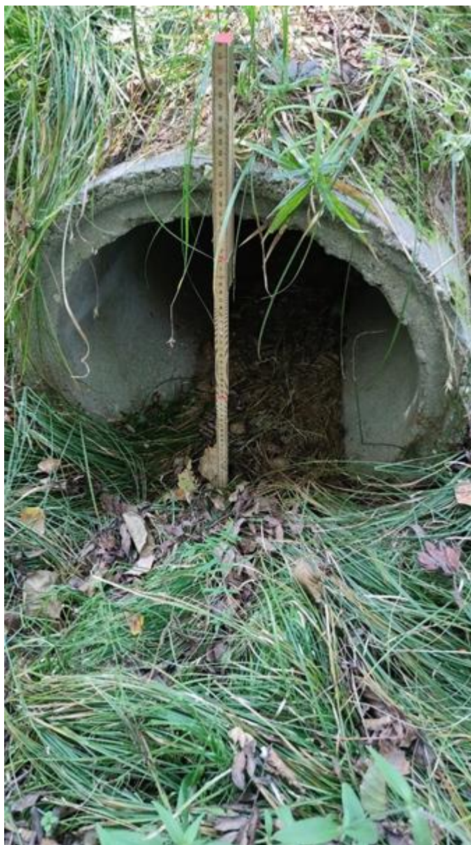
Ryc. 12.7. Przykład betonowego przepustu okularowego podczas pomiaru średnicy w oddziale 153D w leśnictwie Przechody, Nadleśnictwo Browsk (źródło: BULiGL)
