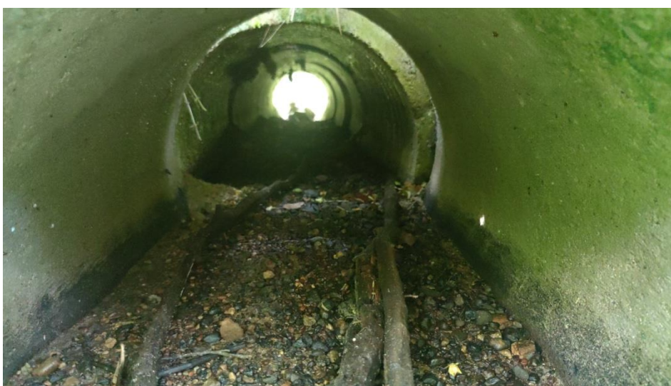
Ryc. 13.7. Przepust częściowo drożny z uszkodzonymi kręgami betonowymi, oddział 274B, leśnictwo Postołowo, Nadleśnictwo Hajnówka (źródło: BULiGL)
