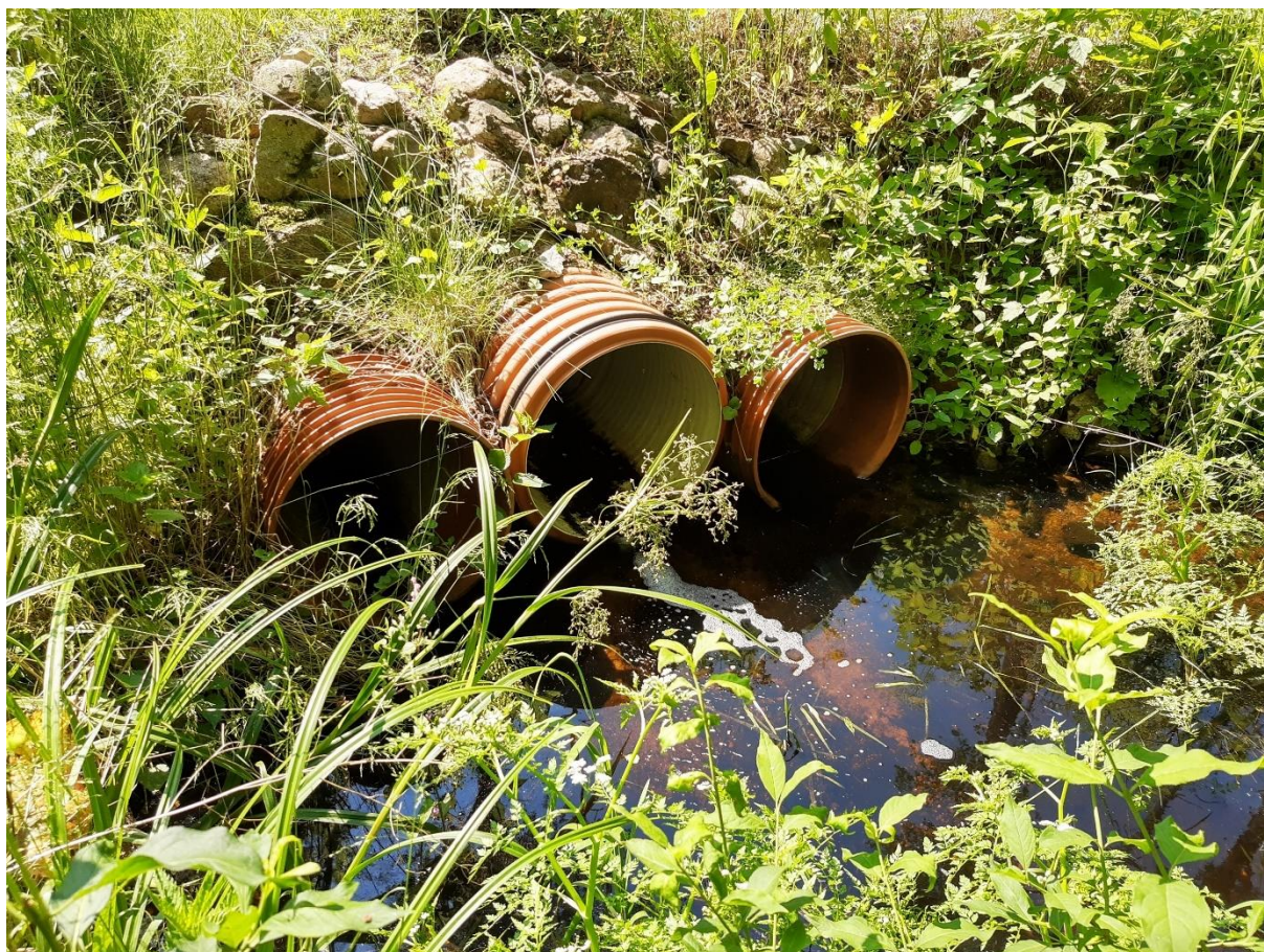
Ryc.12.8. Przykład przepustu okularowego (potrójnego) z tworzywa sztucznego w oddziale 395A w leśnictwie Batorówka, Nadleśnictwo Białowieża (źródło: BULiGL)
